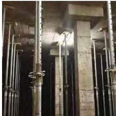
La dalle de la fosse a été temporairement consolidée suite à son usure en surface (apparition de la ferraille du béton).
