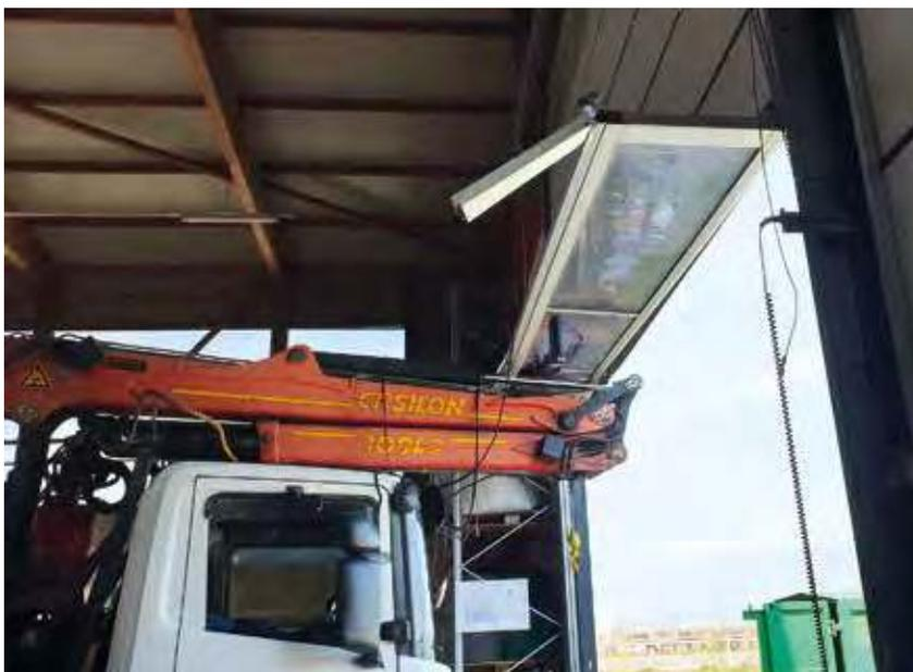
La porte de la halle de transfert a été remplacée suite à un accident. Un système de régulation des entrées dans la halle a été mis en place.
