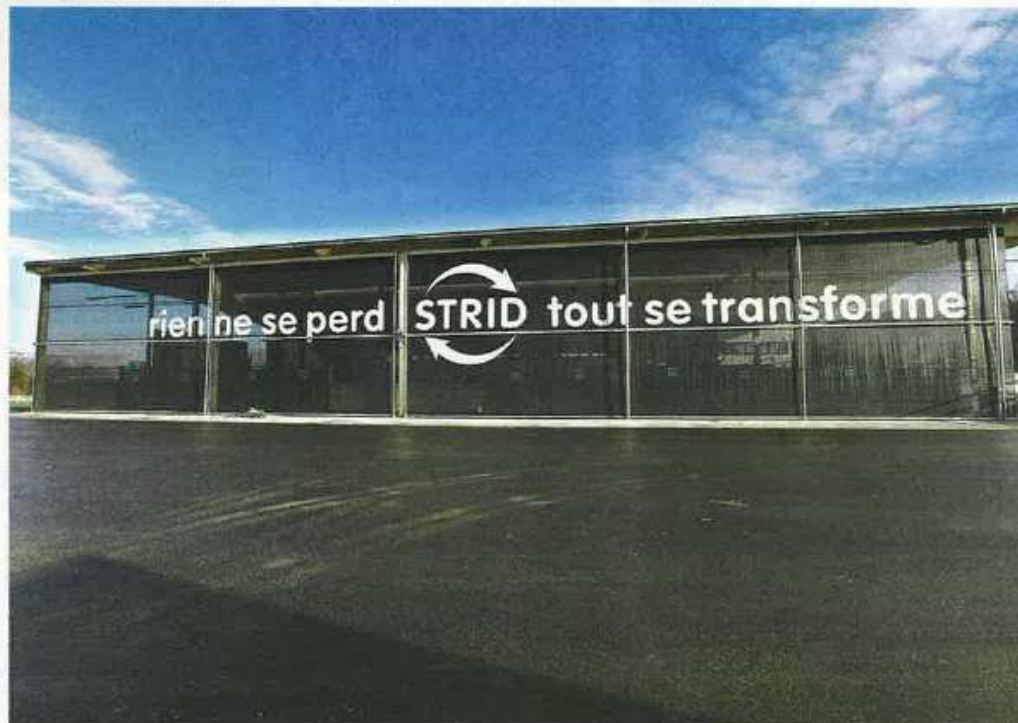
Le filet latéral protégera les usagers du vent et de la pluie. Il peut être facilement monté pour permettre aux camions d'embarquer les bennes de 36 m 3 .
