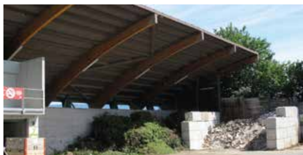
Couvert durant les travaux
